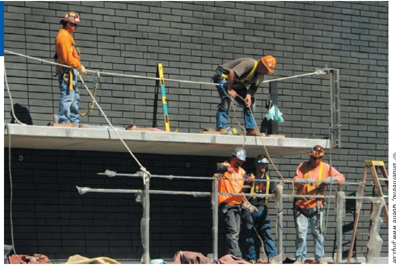
Bauarbeiter arbeiten an einer Häuserfassade in Los Angeles
